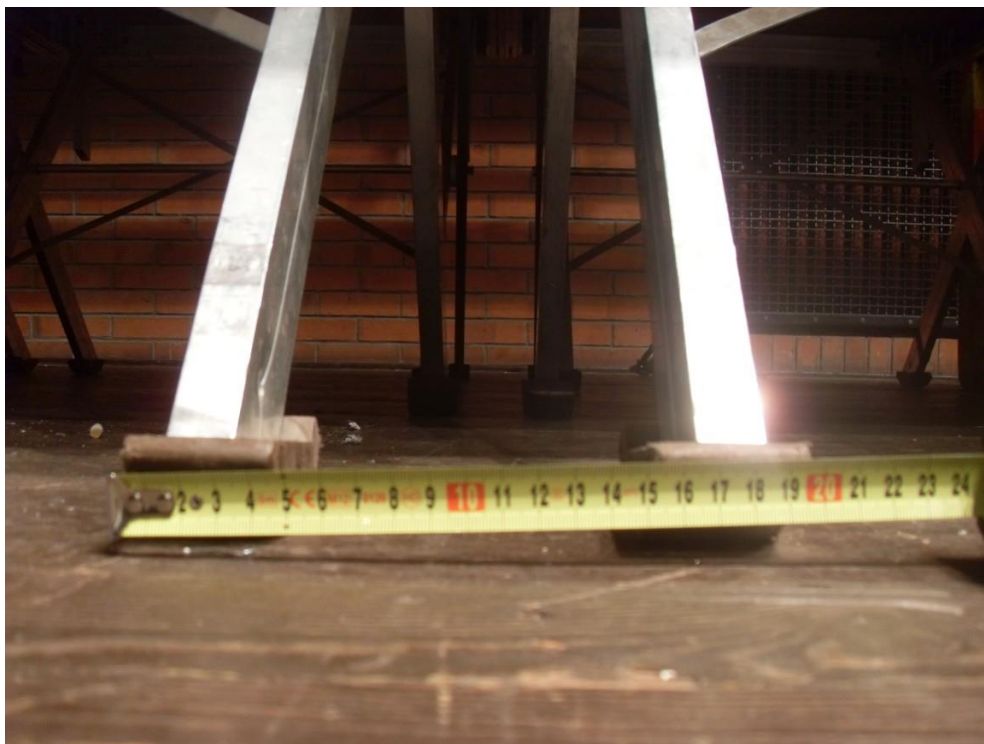
Příloha č. 2: Detail vnitřních nohou dvou praktikáblů vedle sebe.
