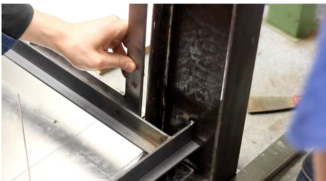
Obr. 63: Svařování nosné konstrukce k nohám stolu
