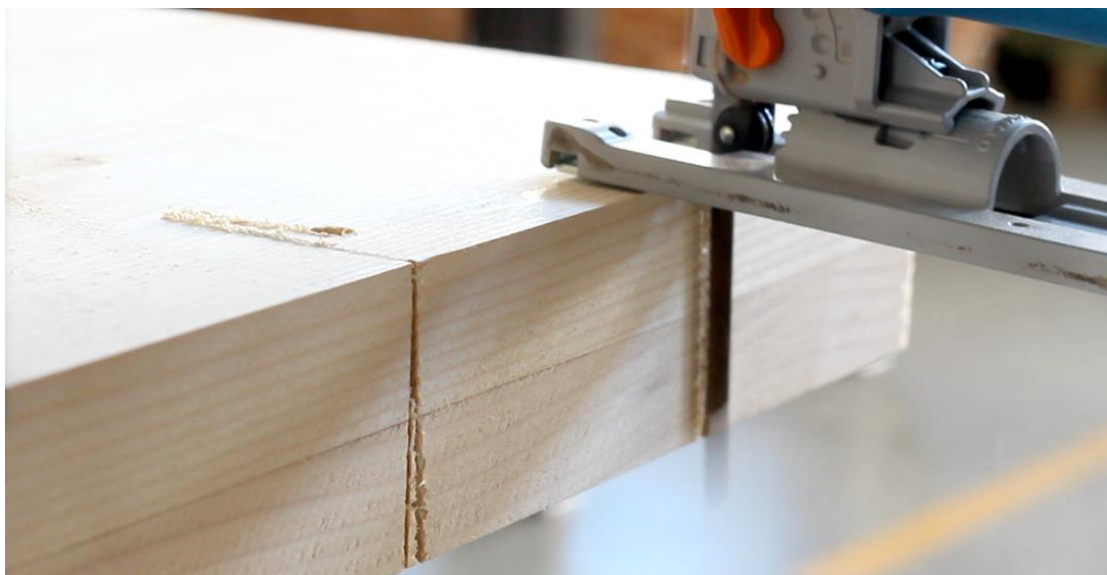
Obr. 75: Vyřezání pro osazení I profilu
