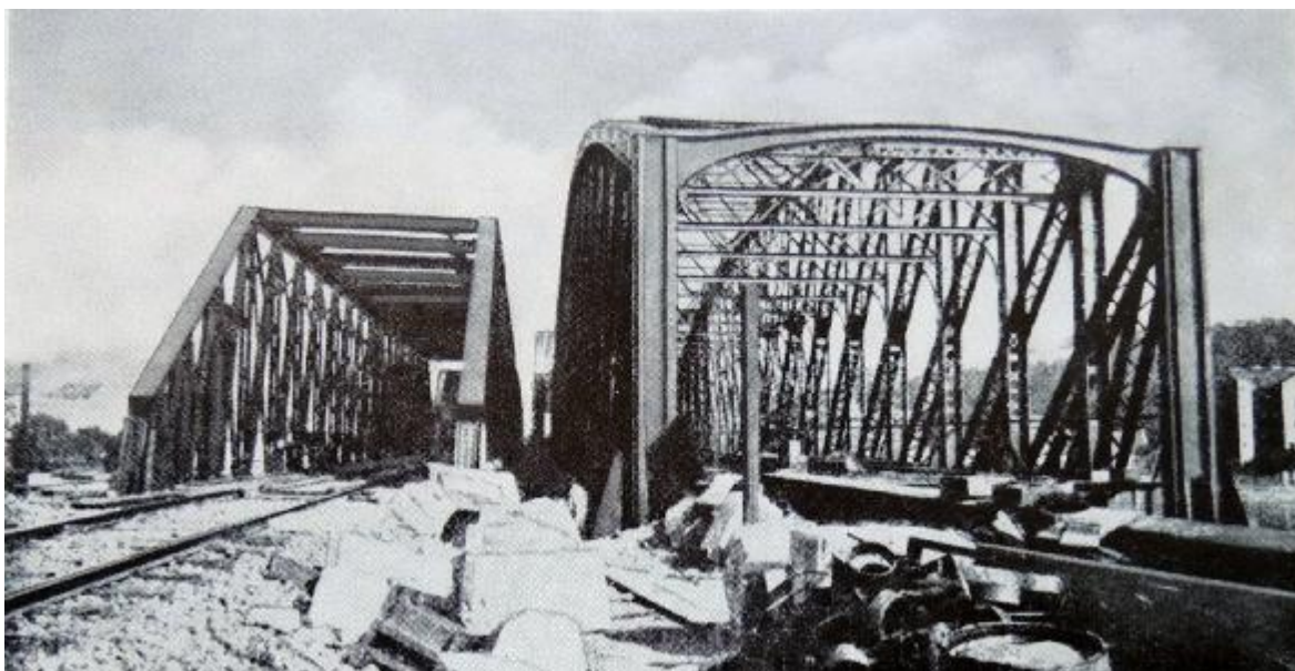
09. Projektant Harkortovy mostárny z Duisburgu (?), Jan Kolář a firma Bratři Prášilové a spol., původní železniční most s mostem novým – 1901. Zdroj: Jan Fischer – Ondřej Fischer, Pražské mosty , Praha 1985.
