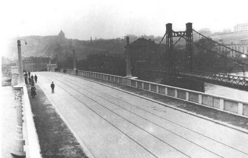
08. Karel Veselý, R. M. Ordish, W. H. Le Feuvre, Rudolfova lávka a nový Mánesův most v roce 1914, 1868-1869. Zdroj: http://www.gemini-praha.org/img.php?1856
