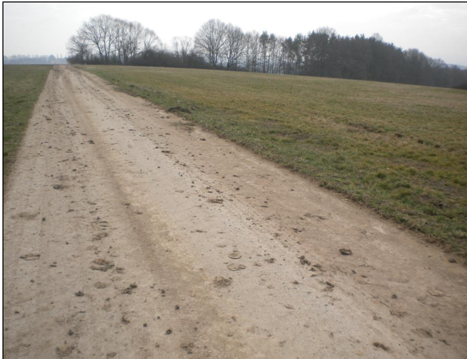
Fotografie č. 28 erozní linie č. 3 a č. 4
