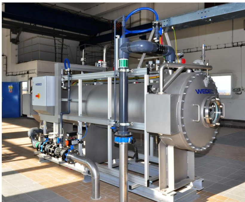
Obr. 6. 5 Ozonizace na úpravně vody Želivka [31]
