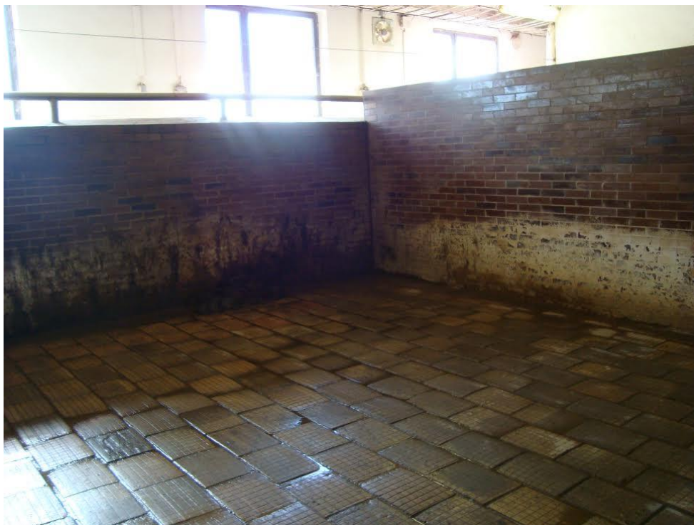
Obrázek č. 28: Příklad vnitřní ubikace
