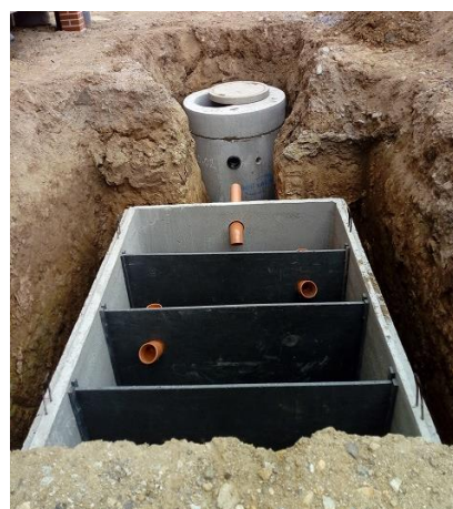
Obr. 4.3 Betonový hranatý vícekomorový septik [27]
