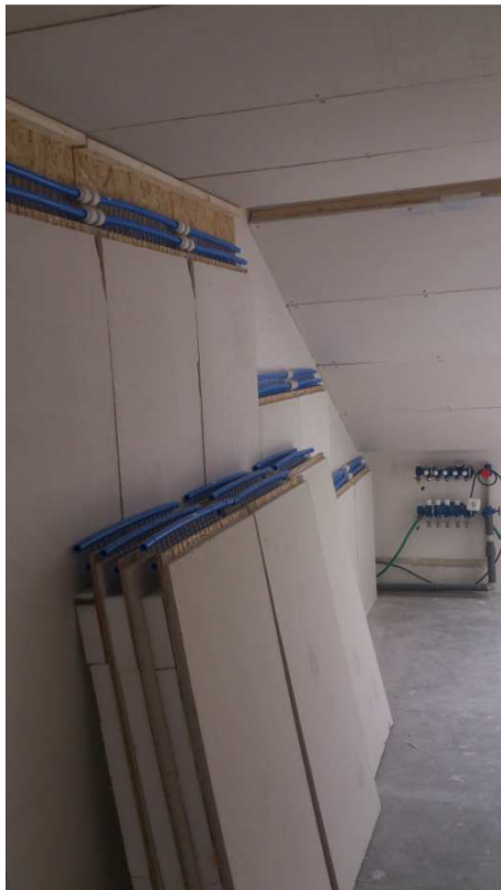
Obr. 11 Montáž tepelně akumulčních panelů (2. sada měření)
