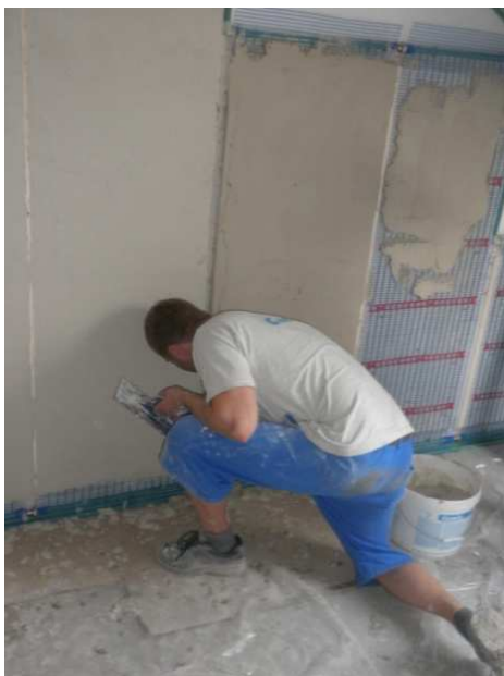
Obr. 9 Výroba tepelně akumulčních panelů (1. sada měření)
