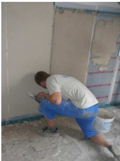
Obr. 9 Výroba tepelně akumulčních panelů (1. sada měření)
