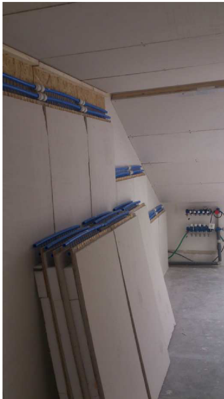
Obr. 11 Montáž tepelně akumulčních panelů (2. sada měření)
