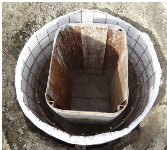
Obr. č. 79 - Bednění a výztuž hlavice piloty [3]
