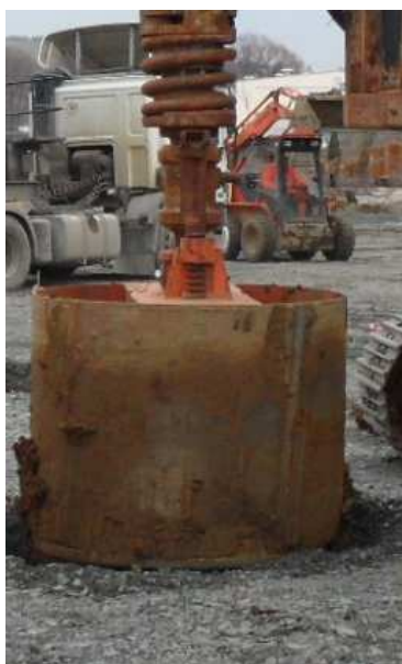
Obr. č. 75 - Vývrt hlavic pilot [2]
