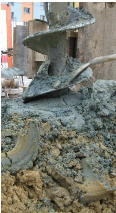
Obr. č. 76 - Vytažení vrtacího šneka [2]
