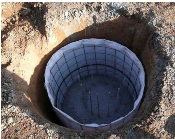
Obr. č. 77 - Zhotovená pilota na dně hlavice [3]
