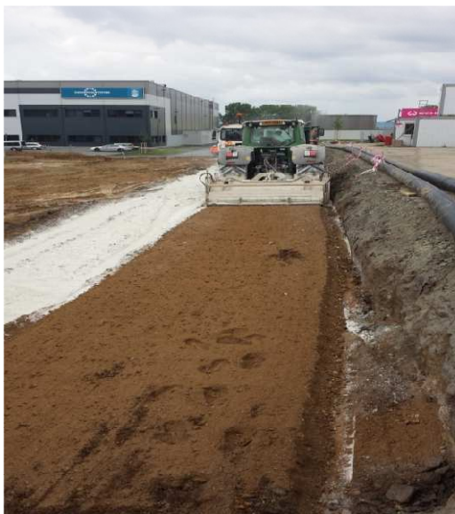
Obr. č. 74 - Zafrézování pojiva [1]
