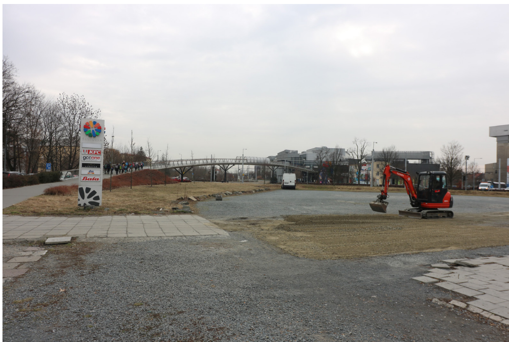
Obr. 8: Pohled na pěší lávku a OC Šantovka, foto vlastní
