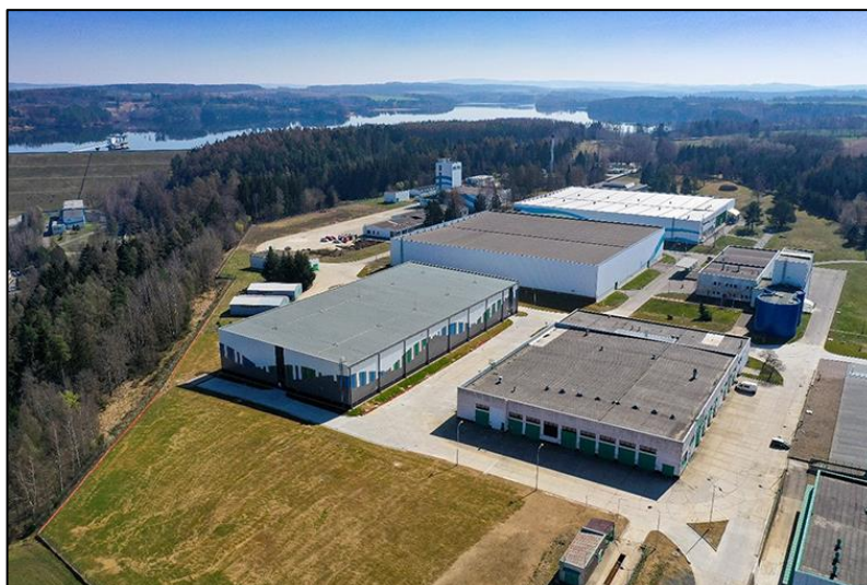
Obrázek 8: Areál úpravny vody Želivka (Sweco, 2022).
