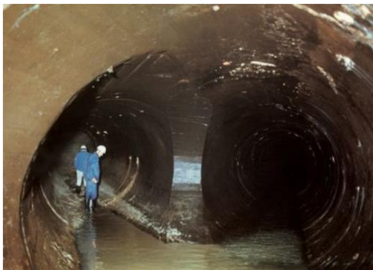
Obrázek 6: Vnitřek štolového přivaděče (Voda a technika, 2021).
