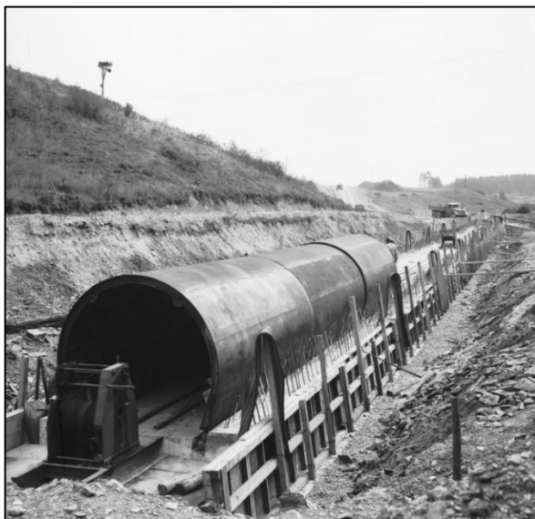
Obrázek 5: Výstavba vodního tunelu (Mapy.cz, 2022).
