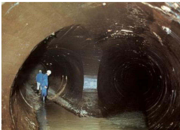
Obrázek 6: Vnitřek štolového přivaděče (Voda a technika, 2021).
