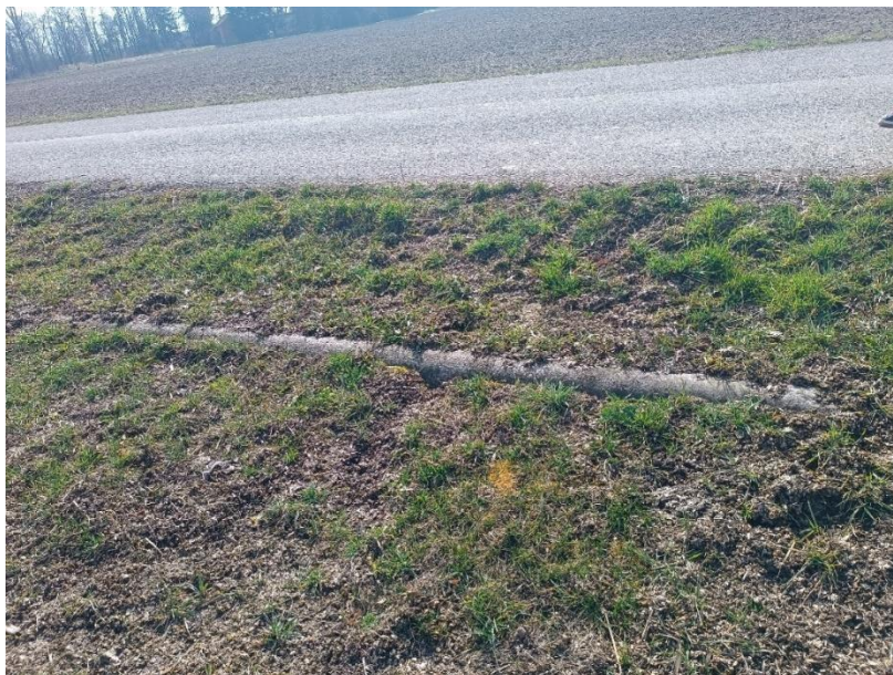
Obr. 18: Kláda v reliktu hráze u rybníka č. 30. (Wiesner J., březen 2023)
