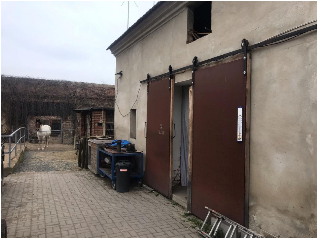
Obrázek 26. Vpravo budoucí skladovací prostory na seno a slámu, vlevo část zpevněného zimního výběhu pro koně a stodola s přístřeškem. Zdroj: Vlastní fotodokumentace
