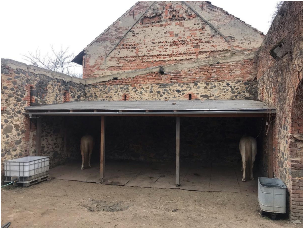
Obrázek 29. Stodola s přístřeškem pro koně. Vlevo nádrž na dešťovou vodu, vpravo napajedlo. Zdroj: Vlastní fotodokumentace
