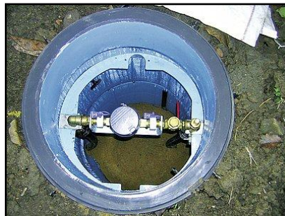
Obr. 6.19 - Vodoměrná šachta (URL 18)
