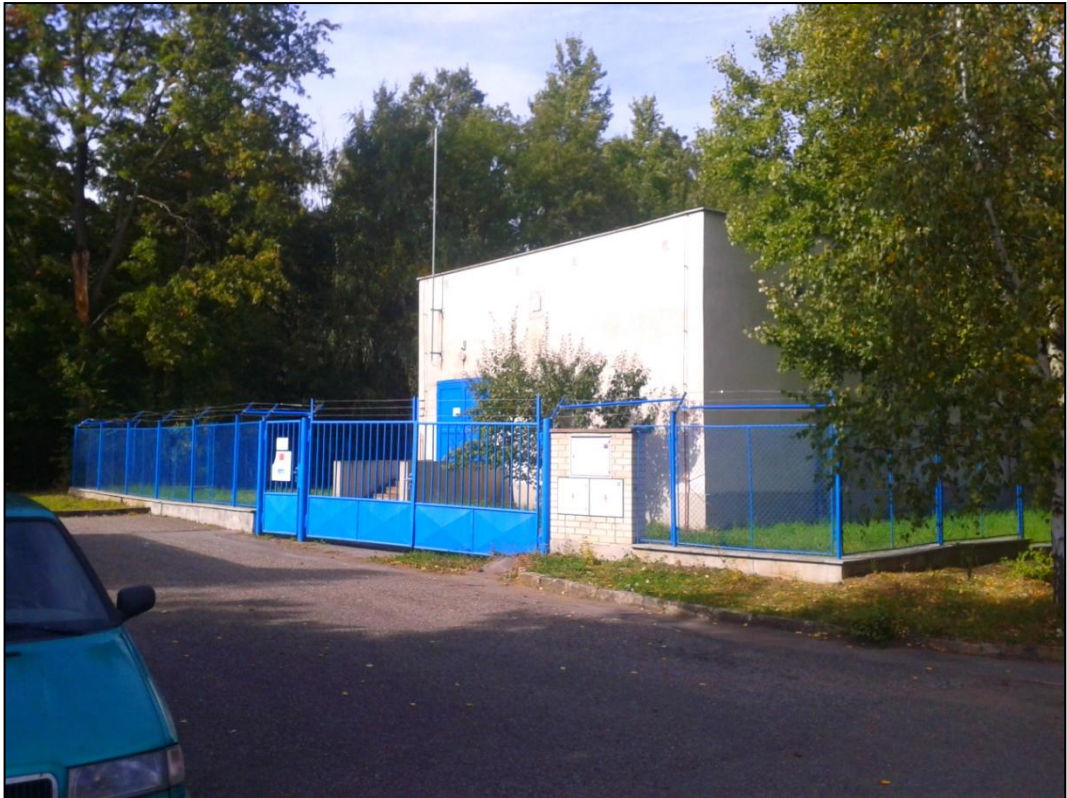
Obr. 3.3 - Pohled na čerpací stanici Rohožník (autor práce 2013)
