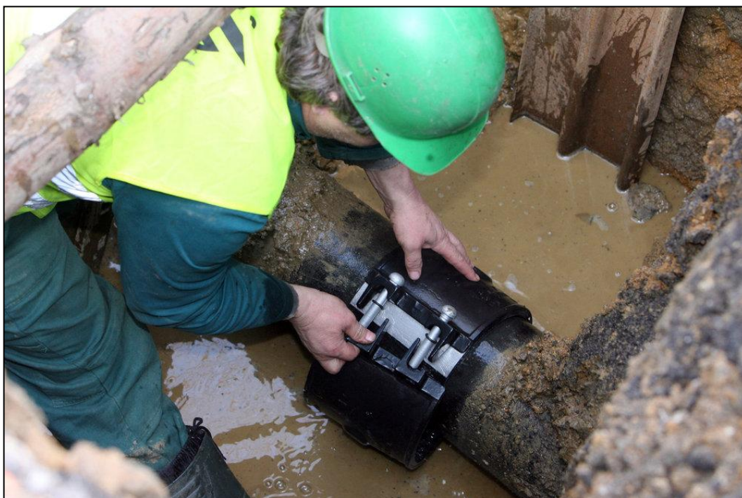
Obr. 3.8 - Oprava příčného lomu ( http://www.ahaonline.cz 2014)
