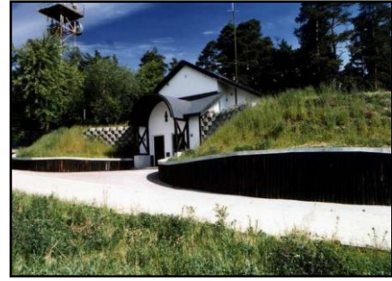
Obr. 6.18 Zemní vodojem (URL 17)
