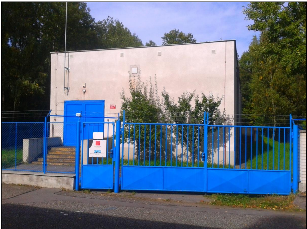
Obr. 3.4 - Pohled na čerpací stanici Rohožník (autor práce 2013)
