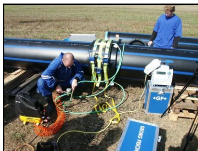
Obr. 6.9 - Svařování elektrotvarovky (URL 9)
