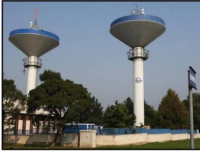
Obr. 6.17 Věžové vodojemy (URL 16)
