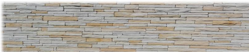
Obrázek 7 - obklad zdiva pískovcem Zdroj: www.krakorka.cz
