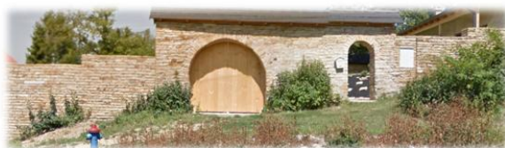
Obrázek 5 Opuková zídka ve Vrchovinách, nedaleko Nového Města nad Metují Zdroj: Google Maps, upraveno
