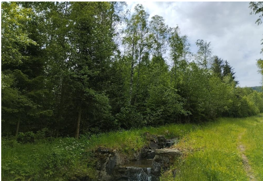
Obr. 30. Stav severního svahu odkaliště v roce 2023 (foto: M. Petřek).
