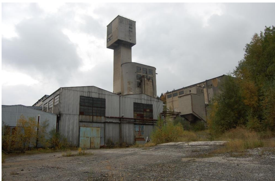
Obr. 23. Okolí těžní věže, stav v roce 2008 (foto: M. Petřek).
