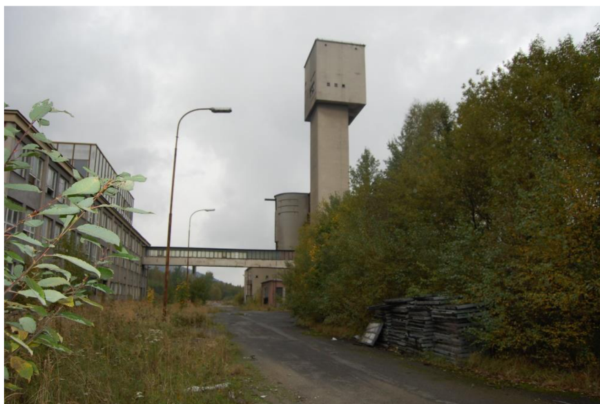
Obr. 14. Pohled na těžní věž v roce 2008 (foto: M. Petřek).
