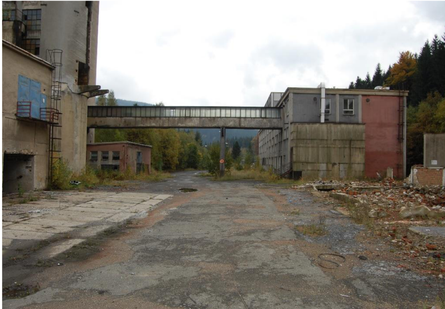
Obr. 25. Pohled na manipulační budovu a spojovací most v roce 2008 (foto: M. Petřek).
