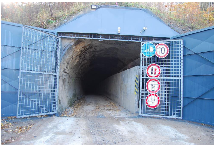
Obr. 34. Pohled na znovuotevřené důlní dílo Úvodní úpadnice (foto: M. Petřek).
