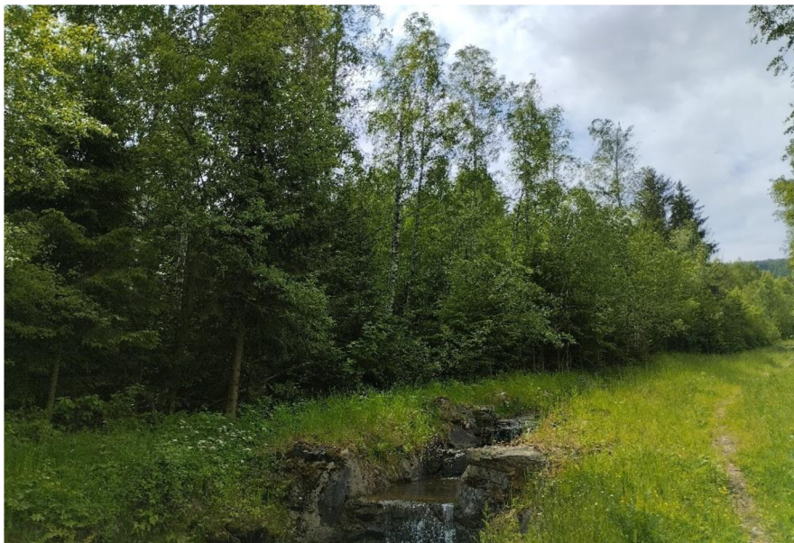
Obr. 30. Stav severního svahu odkaliště v roce 2023 (foto: M. Petřek).
