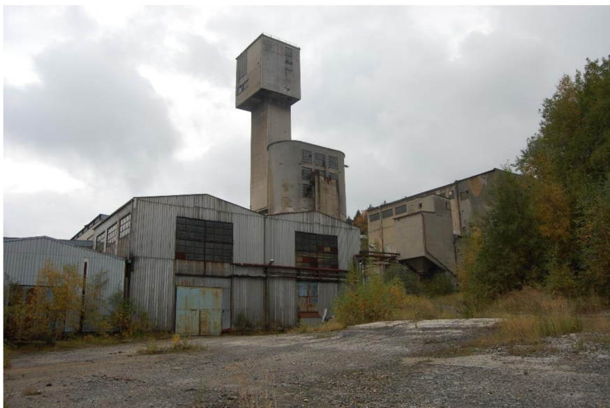
Obr. 11. Součástí technické fáze rekultivací je i odstranění pozemních objektů a technického zázemí dolu, Zlaté Hory stav v roce 2008 (foto: M. Petřek).
