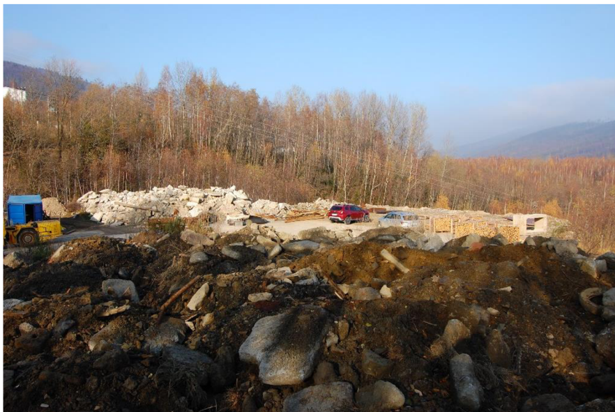
Obr. 38. Materiál větší frakce je nutno podrtit (foto: M. Petřek).
