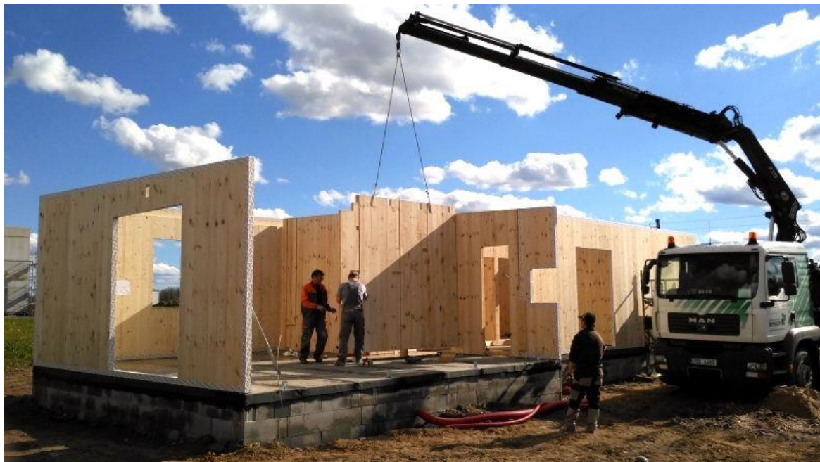
Obr. 14 Umisťování CLT panelu pomocí jeřábu (Nešporová 2017)
