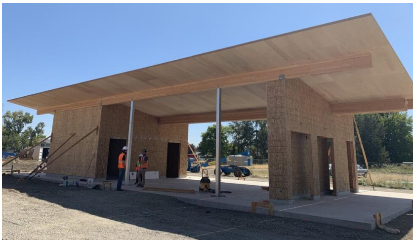
Obr. 31 MPP v aplikaci jako střešní panel (Freres Lumber Co. Inc. 2021)
