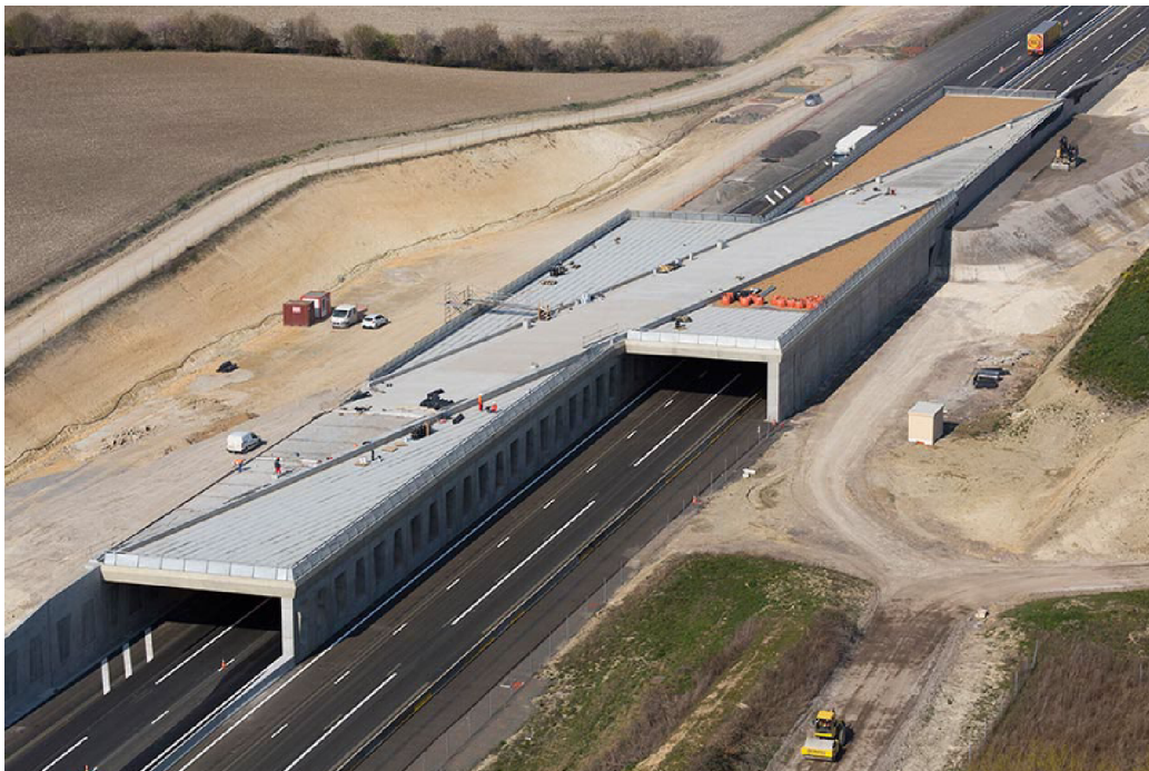
Obr. 3 Příklad rámového přemostění z předpjatého betonu pro křížení dálnice s VRT – LGV Sud-Europe Atlantique (Francie) (6)
