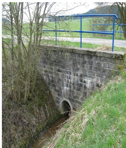
Foto č. 17 Vyústění propustky pod silnicí Strželec – Janovská Lhota.
