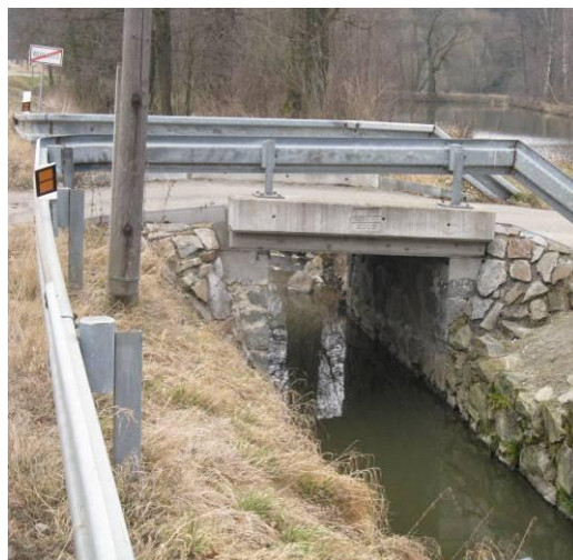
Foto č. 29 Příjezdový železobetonový most. (ZEMAN 2012)
