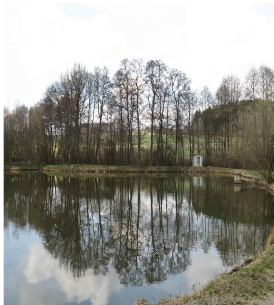
Foto č. 6 Pohled z hráze rybníka v Hlivíně.
