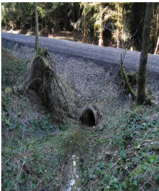
Foto č. 12 Propustka pod lesní cestou vyřešená betonovou rourou.
