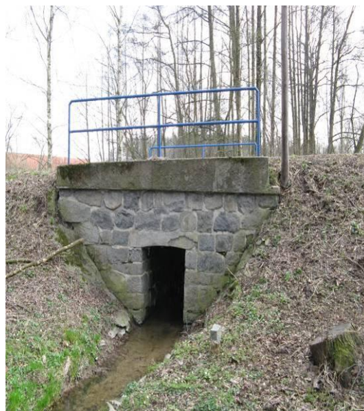
Foto č. 15 Kamenná propustka s betonovým překladem na nejdelším přítoku pod silnicí Hlivín-Vojslavice.
