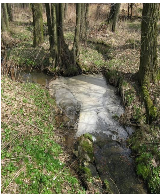
Foto č. 16 Konec opevněného koryta na kraji lesa.
