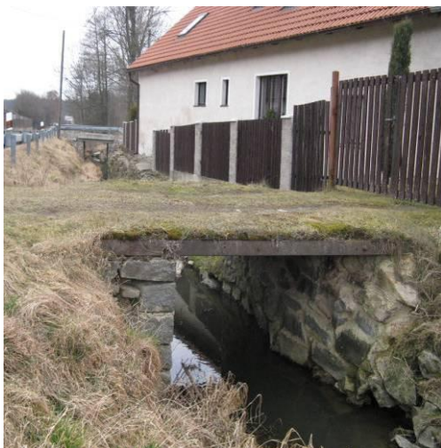
Foto č. 28 Příjezdový most na pozemek.
