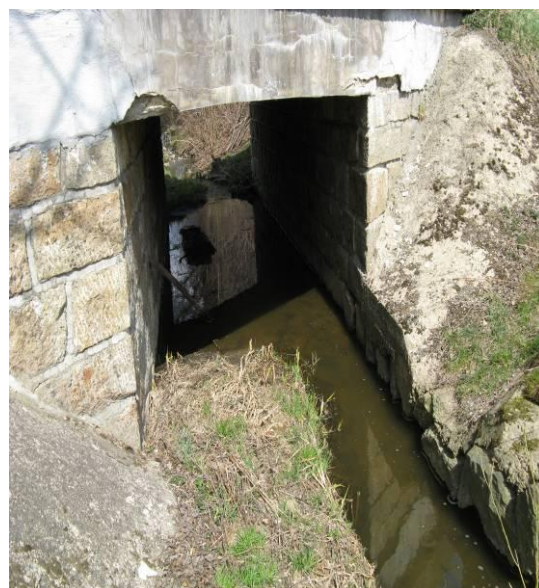
Foto č. 8 Propustek pod silnicí Strženec - Vojslavice. Kombinace kamene železobetonové desky.
