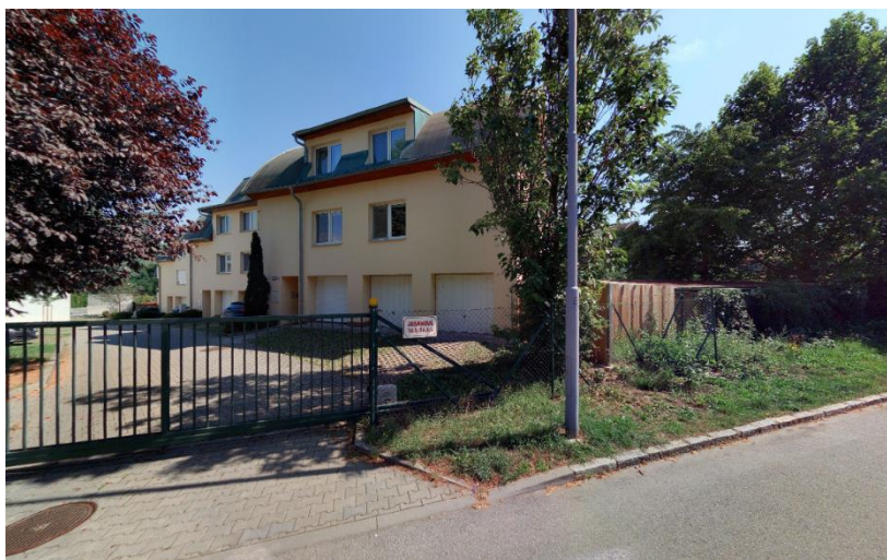
Obr. 101 – Bytový dům - Brno Jundrov – Jasanová [82]
