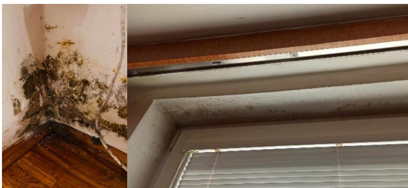
Obr. 173 - Výskyt plísní ve sledovaných objektech
