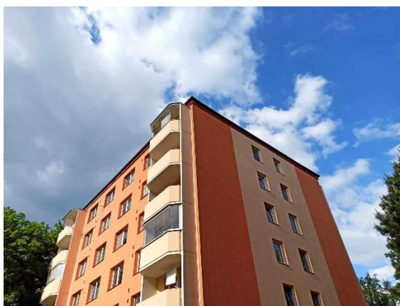
Obr. 103 - Panelový dům – Brno Slatina
