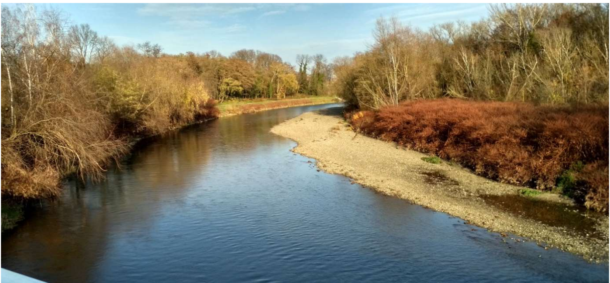
Obr. 16 – Pohled protiproudě z mostu u Lipníku nad Bečvou, ř. km 27,446 (foto autor)
