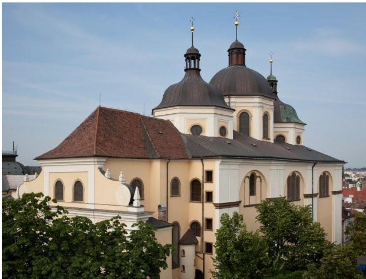
Obr. 1 – Kostel sv. Michala v Olomouci, pohled ze střechy vily Primavesi.
