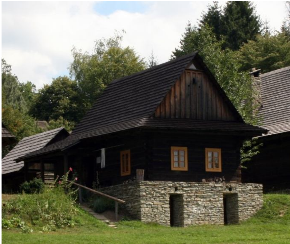
Obr. 5.3 Chalupa z Nového Hrozenkova č. p. 536 [upraveno 21]
