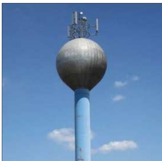
Obr. č. 3.3: Vodojem ( http://vodojem.cz ).
