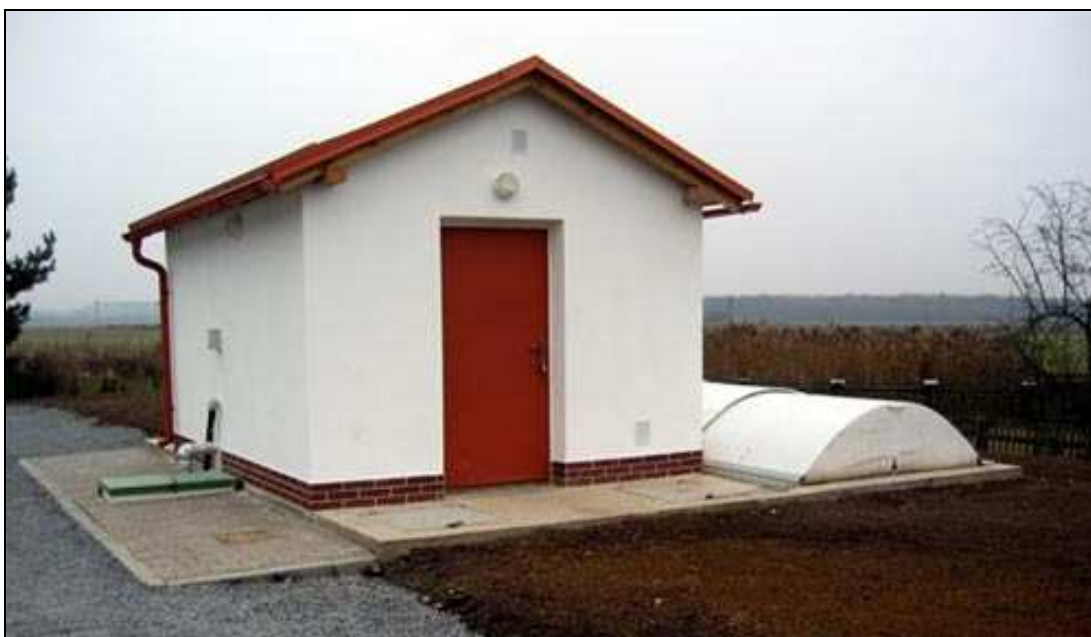
Obr. č. 5.3: Venkovní pohled na ČOV Monoblok – T (www.topolwater.com).
