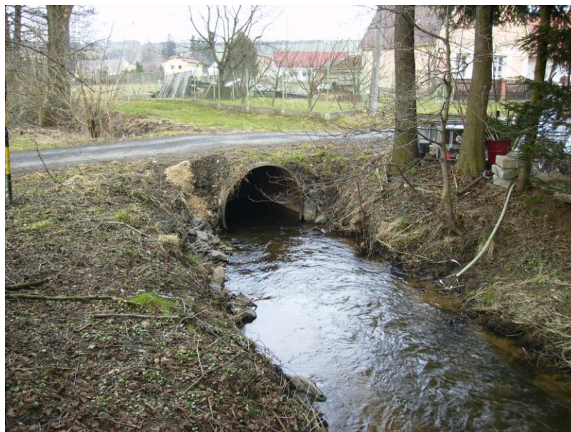
Obr. 13: Propustek na Mochtínském potoce v ř. km 3,800
