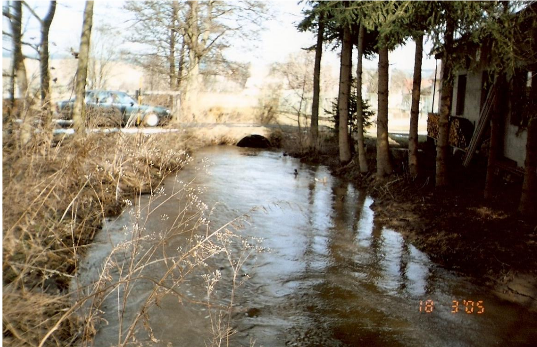
Zvýšená hladina vody při jarním tání v březnu 2005 Propustek na Mochtínském potoce - vpravo objekt sklenářství (Zdroj: J. Kantová)
