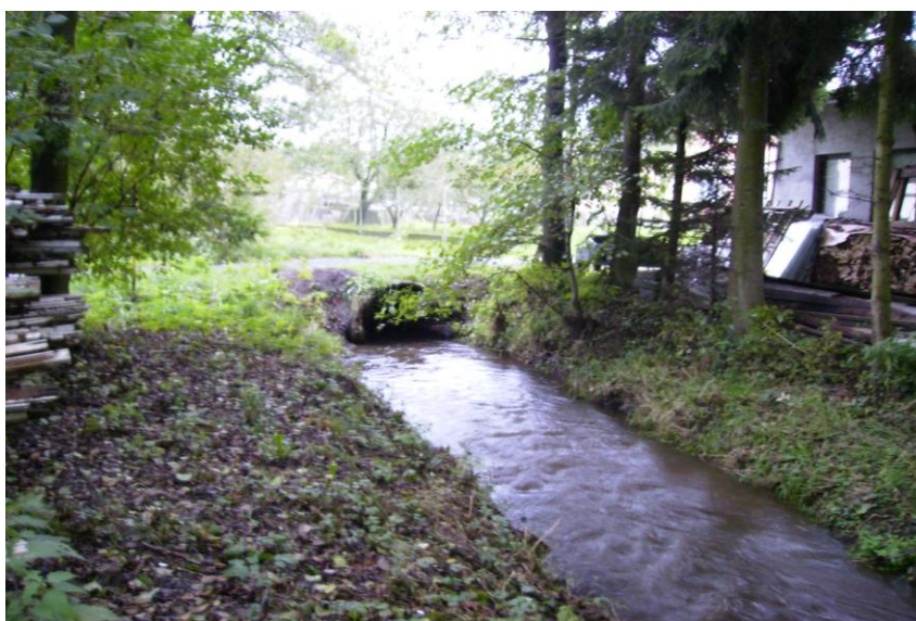
Obr. 25: Propustek na Mochtínském potoce v km 0,312 (Zdroj: vlastní)
