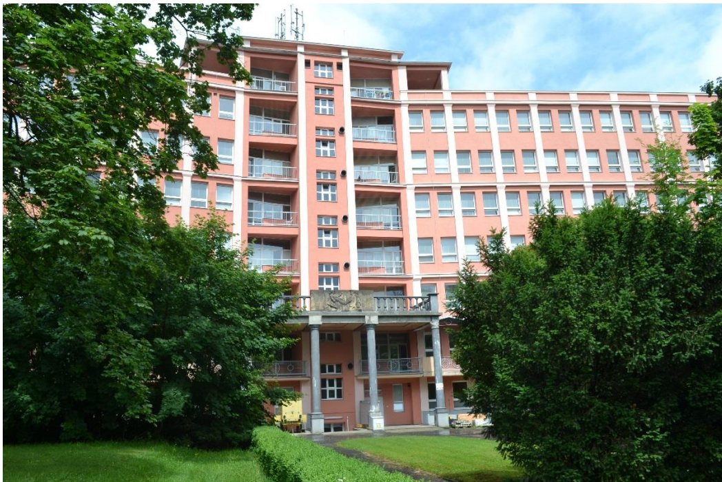
57. Zdeněk Alexa - Zdeněk Strnadel, Okresní nemocnice Ráj – zadní část, 1951. Foto: fotografie autorky, léto 2014
