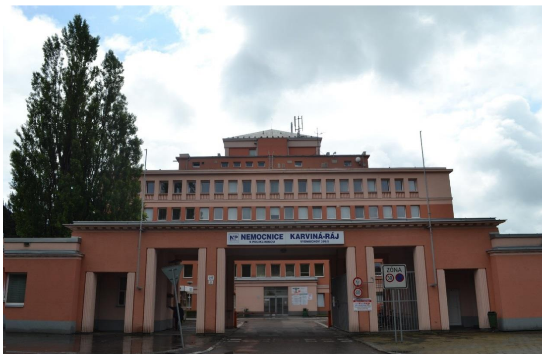
59. Zdeněk Alexa - Zdeněk Strnadel, Okresní nemocnice Ráj – před část, 1951. Foto: fotografie autorky, léto 2014.
