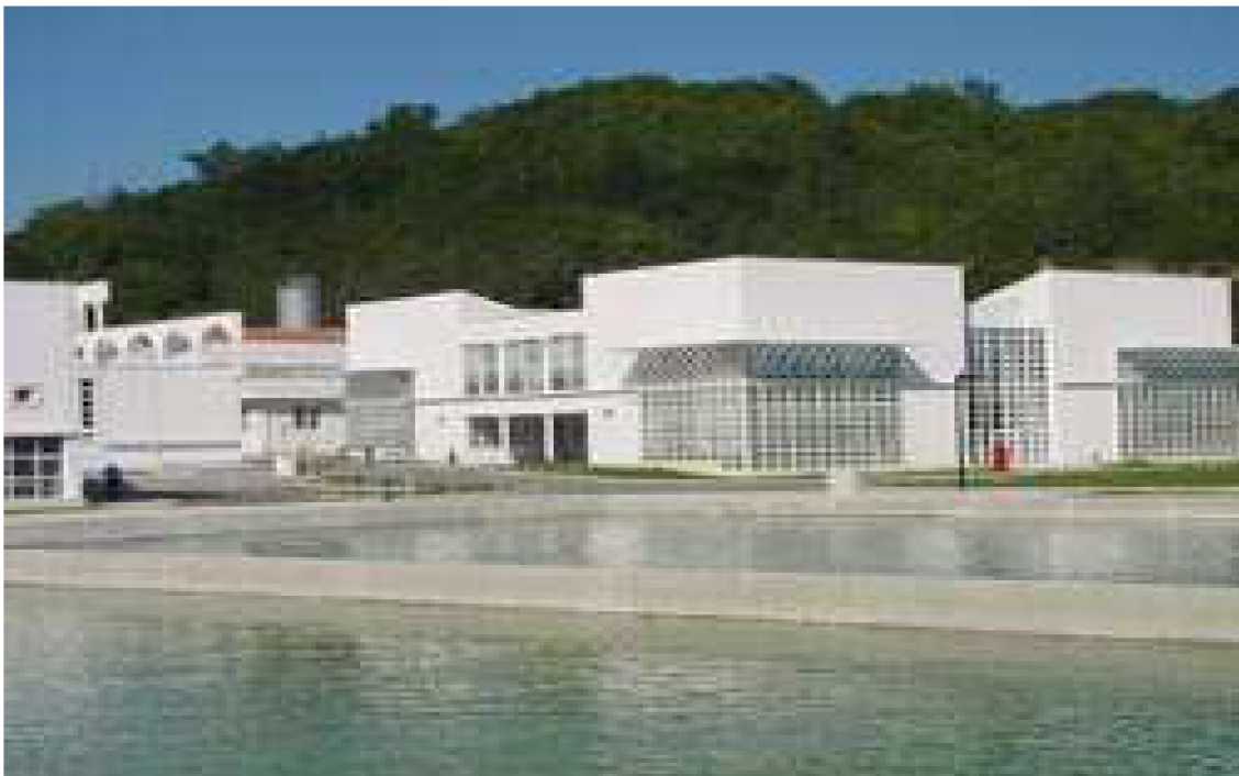
Obrázek 6: Úpravna pitné vody, Butoniga, Chorvatsko (Zdroj: 10)
