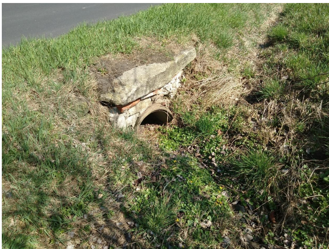
Obrázek č. 10: Propustek na křížení Kaštické strouhy a silnice III/2247
