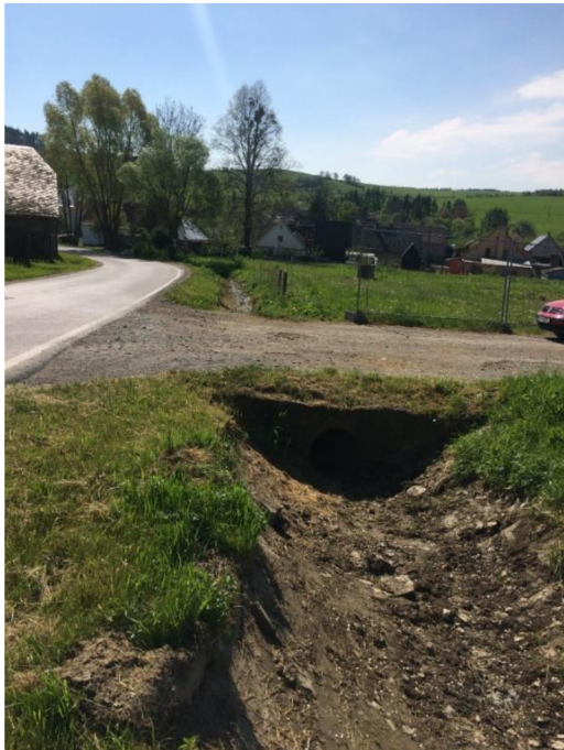
Obrázek 8 - Propustek pro převod vody do řeky Čížiny - 2. kritické povodí
