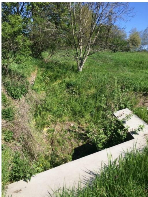
Obrázek 17 - Betonový propustek se zachycením 8. kritického povodí
