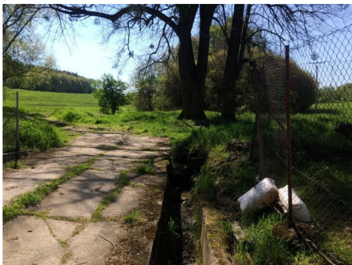
Obrázek 11 - Pohled na vnik eroze do intravilánu pro 4. kritické povodí
