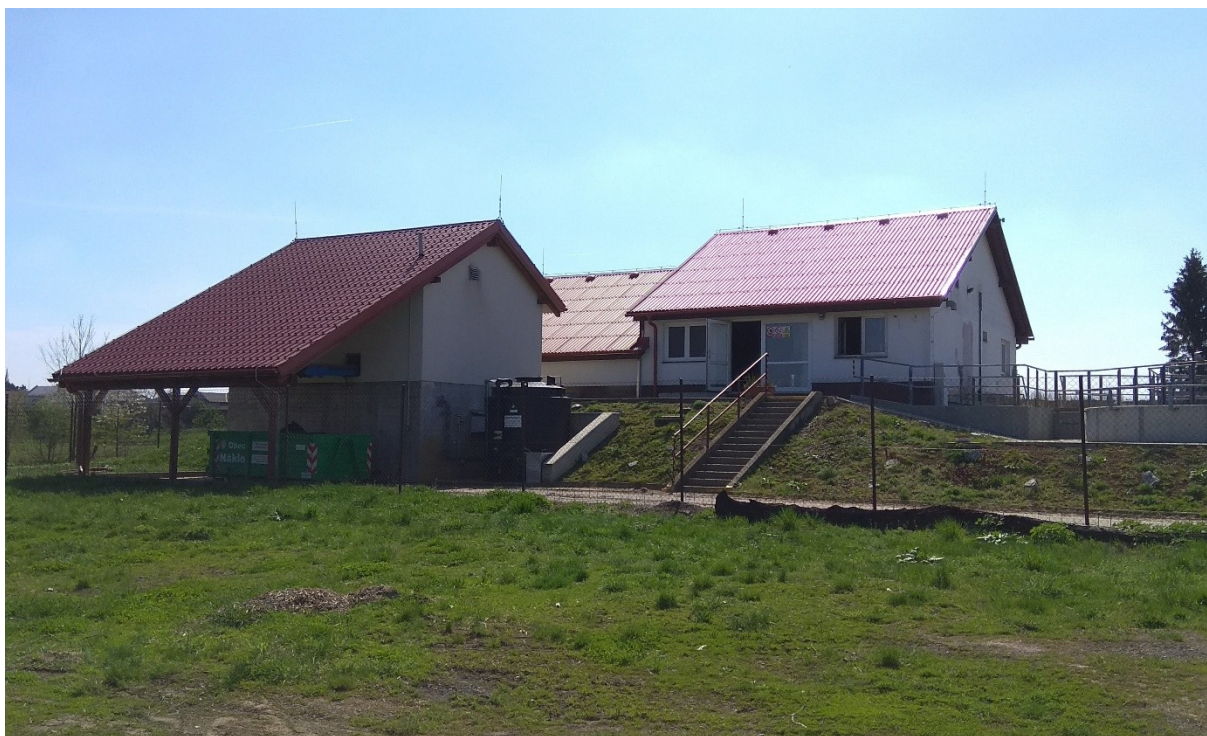
Obrázek 1 – Čistírna odpadních vod Náklo
