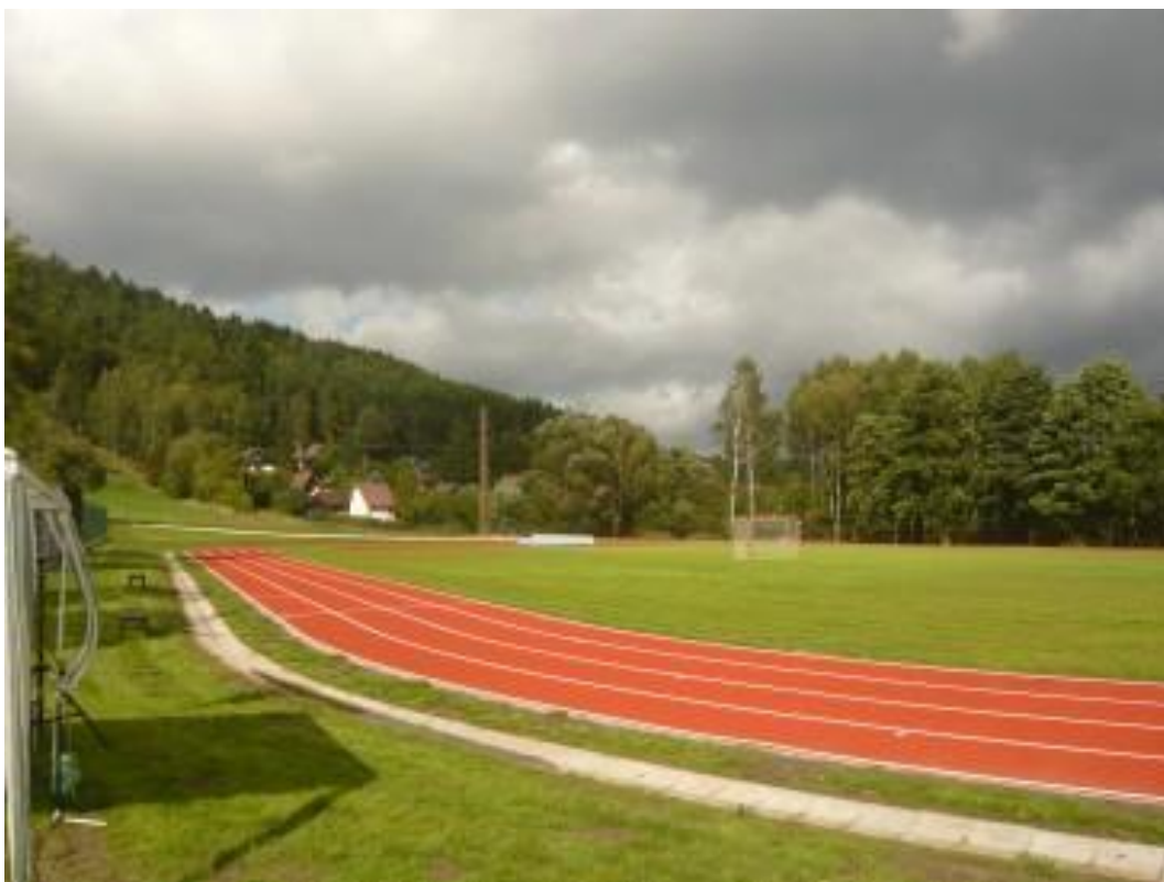
Obrázek č.12: Multifunkční veřejné sportoviště v Hroznětíně
