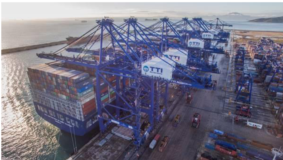
Obr.5 Vykládání kontejnerů pomocí nábřežních jeřábů [12]
