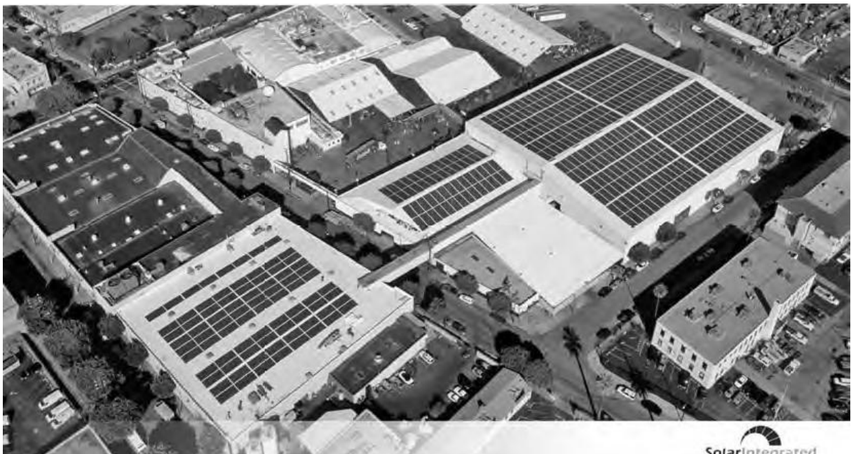
Obr. 2.2.1.2: Pokrytí výrobní haly Coca-Cola tenkovrstvými panely v Los Angeles (350kW AC) [1]
