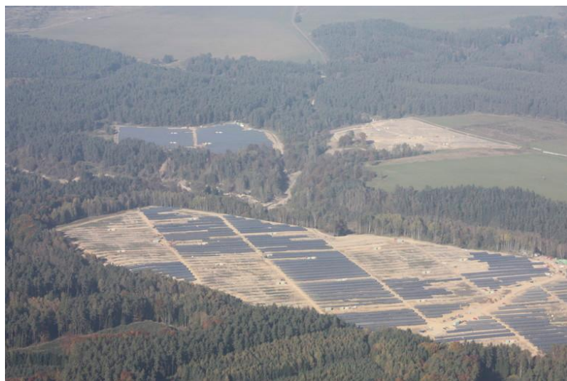
Obr. 3.3.1 Fotovoltaická elektrárna Ralsko [10]
