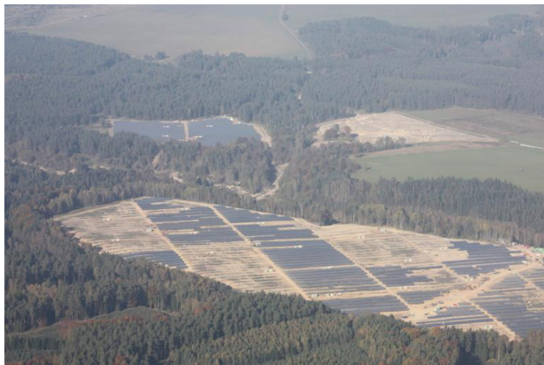
Obr. 3.3.1 Fotovoltaická elektrárna Ralsko [10]
