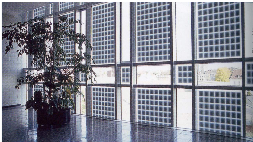
Obr. 2.7.3: Semitransparentní FV výplně – budova STAWAG, Aachen, Německo [2]
