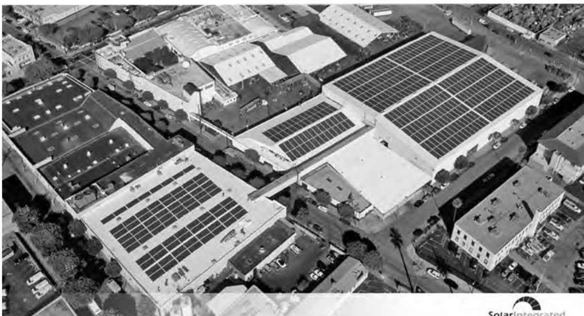
Obr. 2.2.1.2: Pokrytí výrobní haly Coca-Cola tenkovrstvými panely v Los Angeles (350kW AC) [1]
