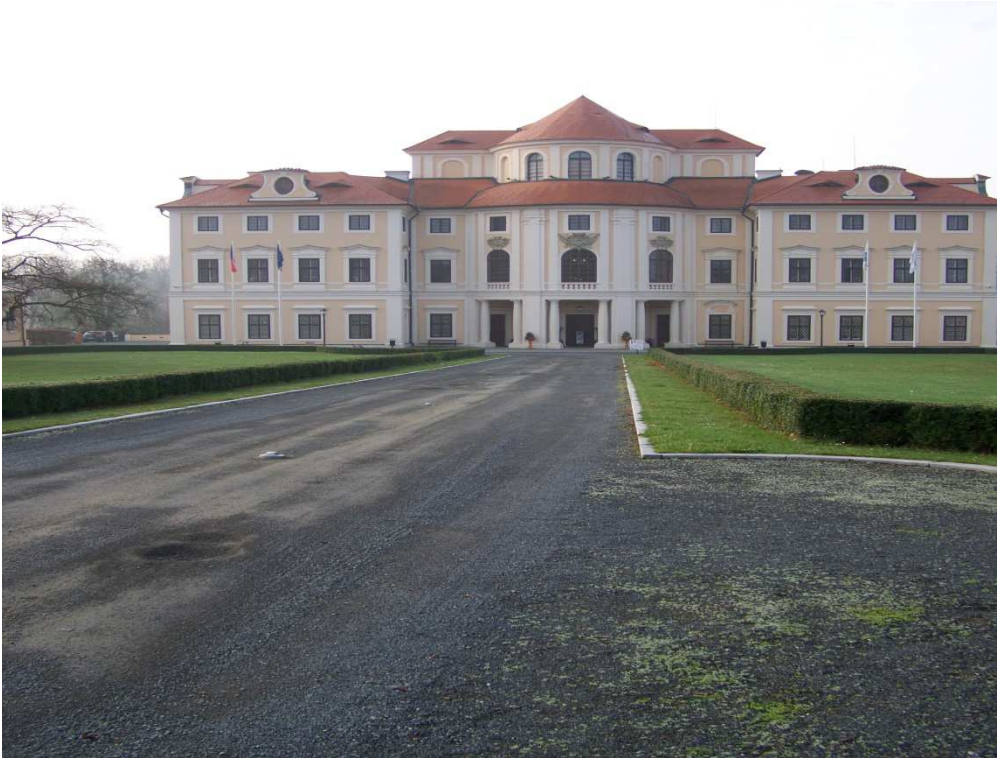
Příjezdová cesta k zámku (zdroj: Kutáčová, 2017).
