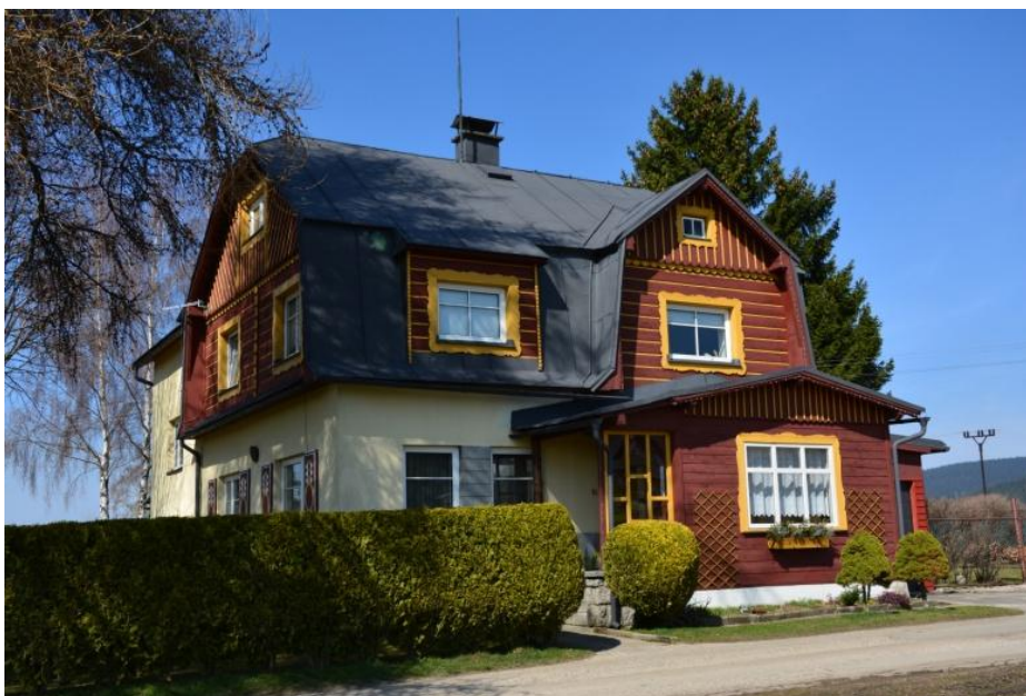
Obr. 59 – Současná podoba bývalé poštovny (Krausová 2016)
