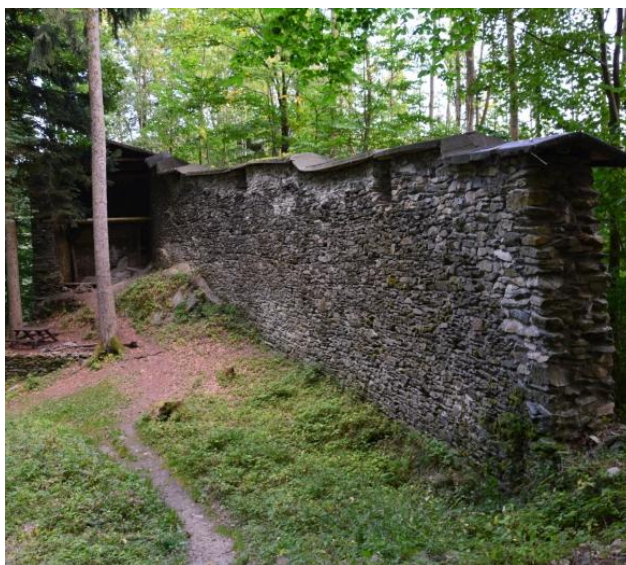
Obr. 63 – Bašta s obvodovým zdivem (Krausová 2016)
