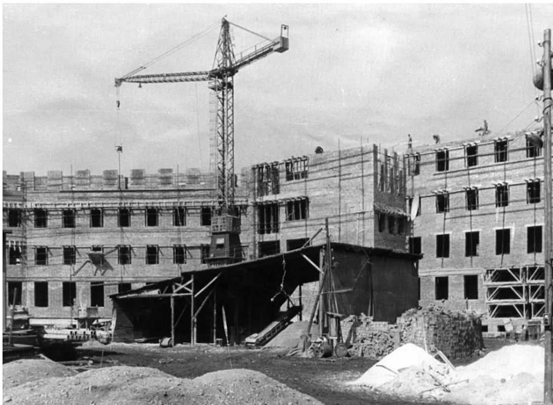
Obrázek 2 - Stavba nové budovy na Chodském náměstí
