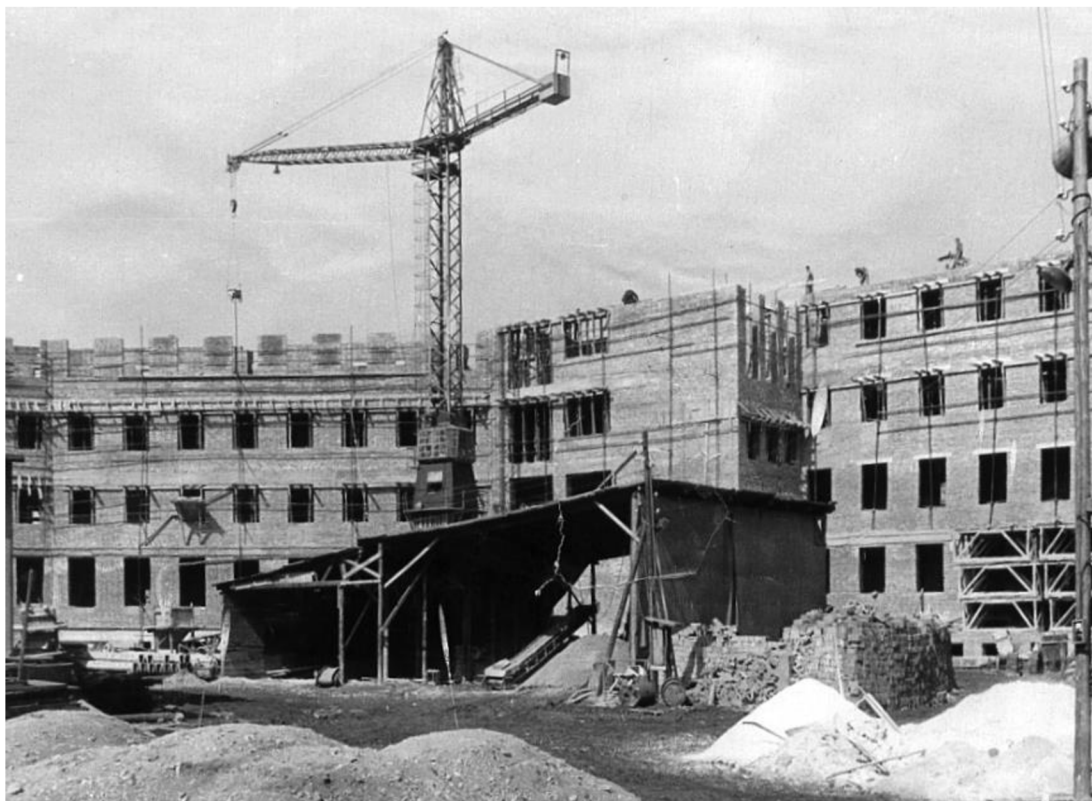
Obrázek 2 - Stavba nové budovy na Chodském náměstí
