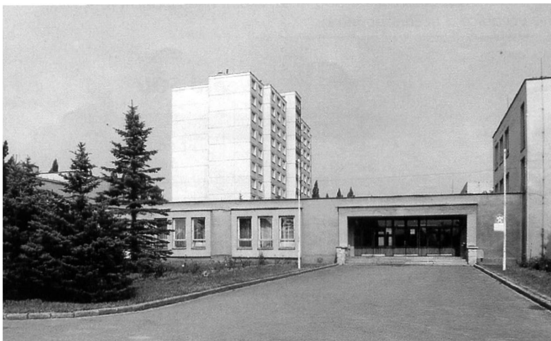
Obrázek 3 - Nově postavená budova SOU na Vejprnické ulici v Plzni
