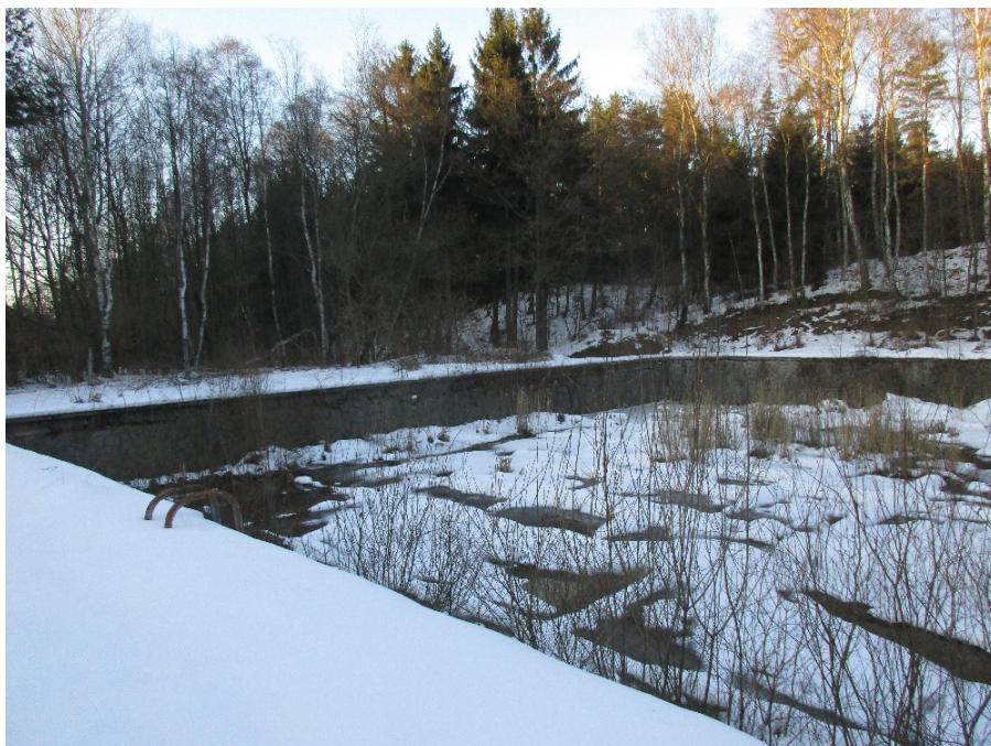
Obr. č. 3: Detailnější pohled na přední část na stávající nádrže
