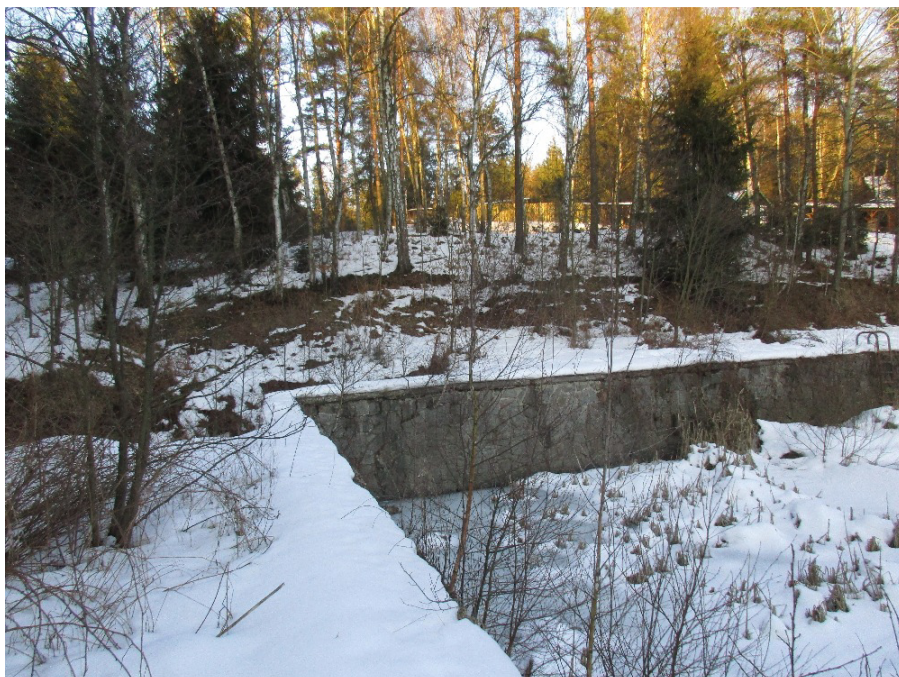
Obr. č. 5: Detail kamenné hráze na stávající nádrži
