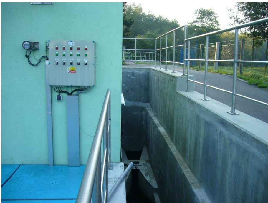
Ovládací zařízení průtokové sondy na odtoku [foto autorka]
