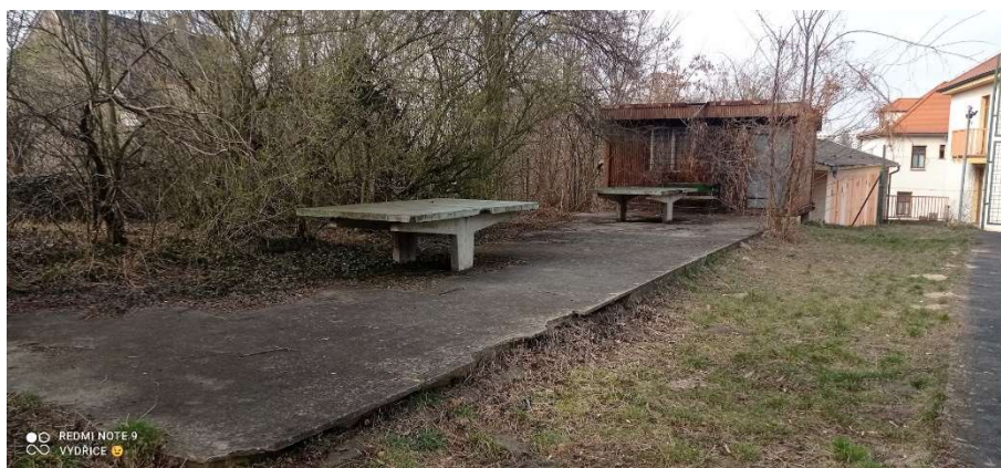
Obrázek. č. 10 Nefunkční stoly na tenis (stav v březnu 2022)
