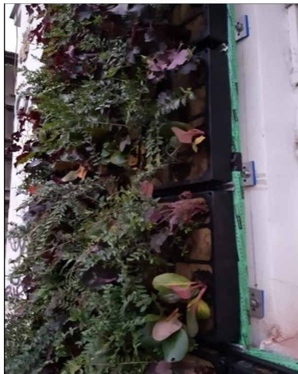
Foto č. 5.1.5.A - Kazetové stěny, Praha
