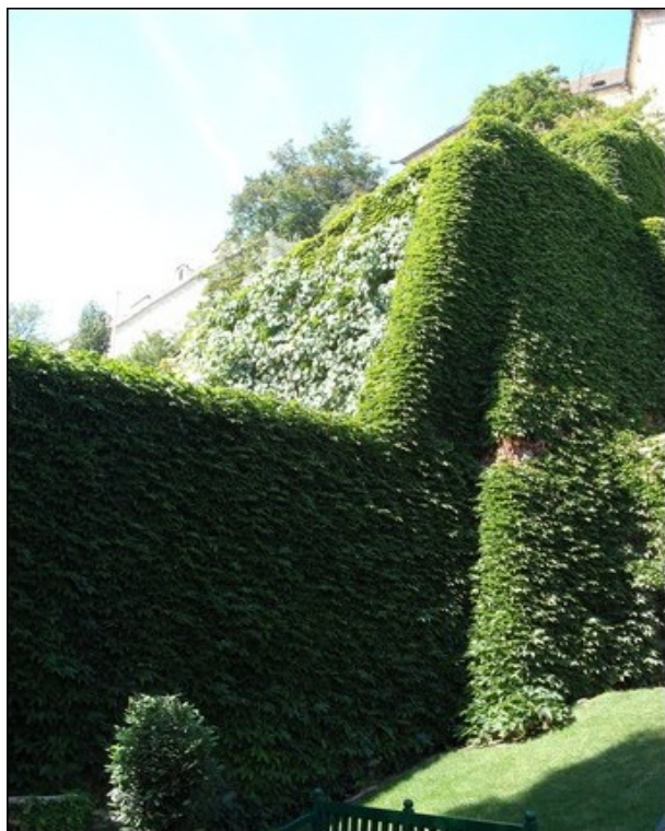
Foto č. 5.1.1.A - Přímé a nepřímé fasády Kolowratská zahrada Praha 2013
