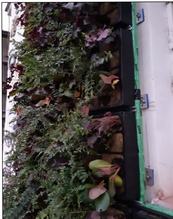
Foto č. 5.1.5.A - Kazetové stěny, Praha
