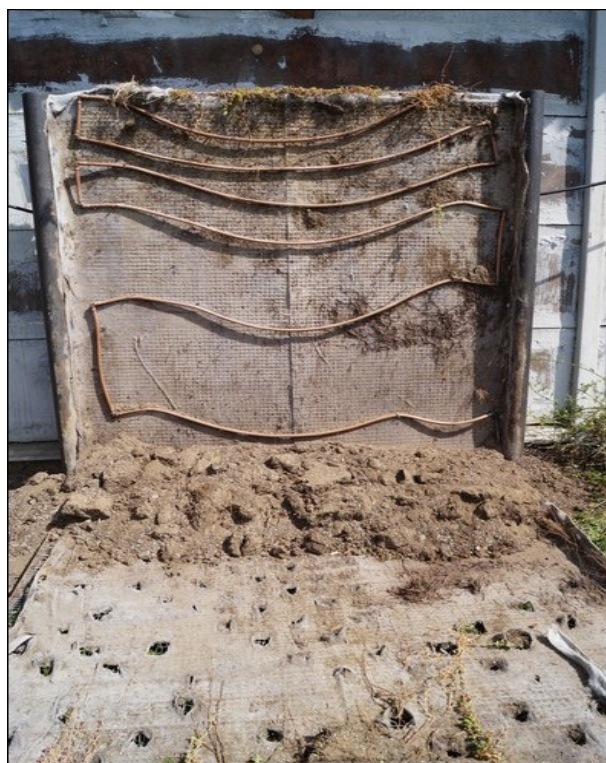
Foto č. 5.3.D - Rozebraná stěna duben 2021
