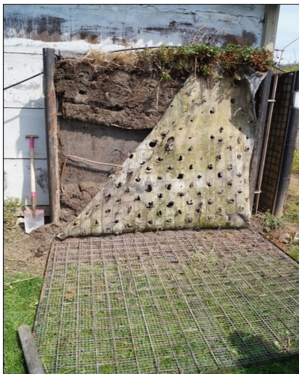
Foto č. 5.3.B - Stará stěna - rozbor duben 2021
