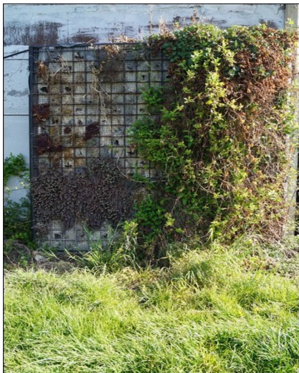
Foto č. 5.3.E - Původní stav stěny jaro 2021
