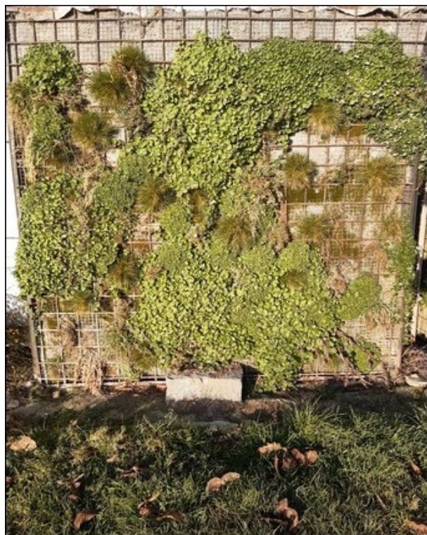
Foto č. 5.3.F - Stav stěny leden 2022
