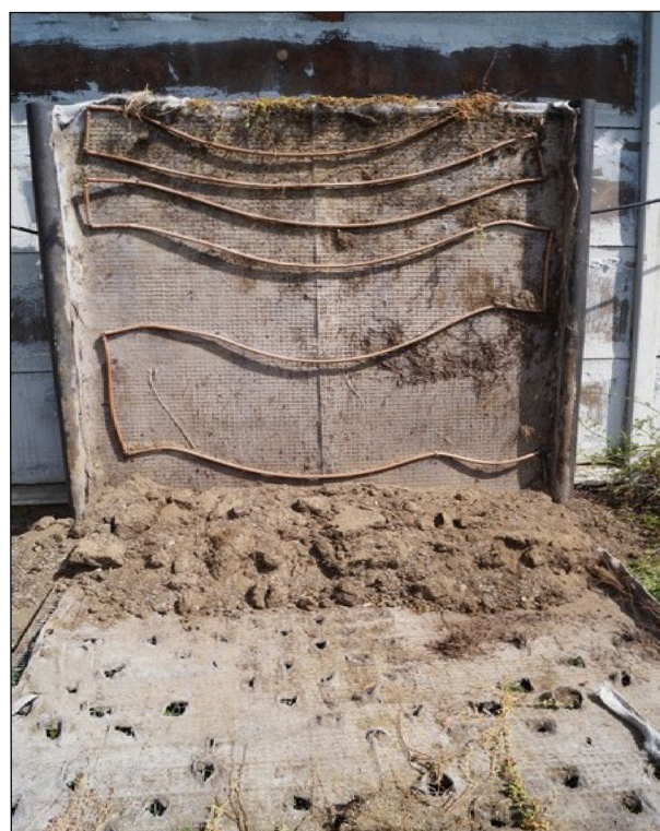
Foto č. 5.3.D - Rozebraná stěna duben 2021
