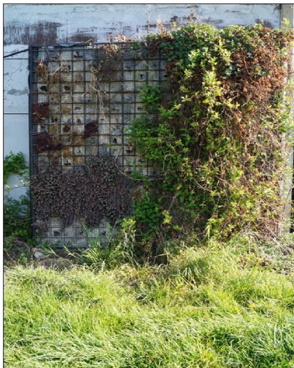
Foto č. 5.3.E - Původní stav stěny jaro 2021
