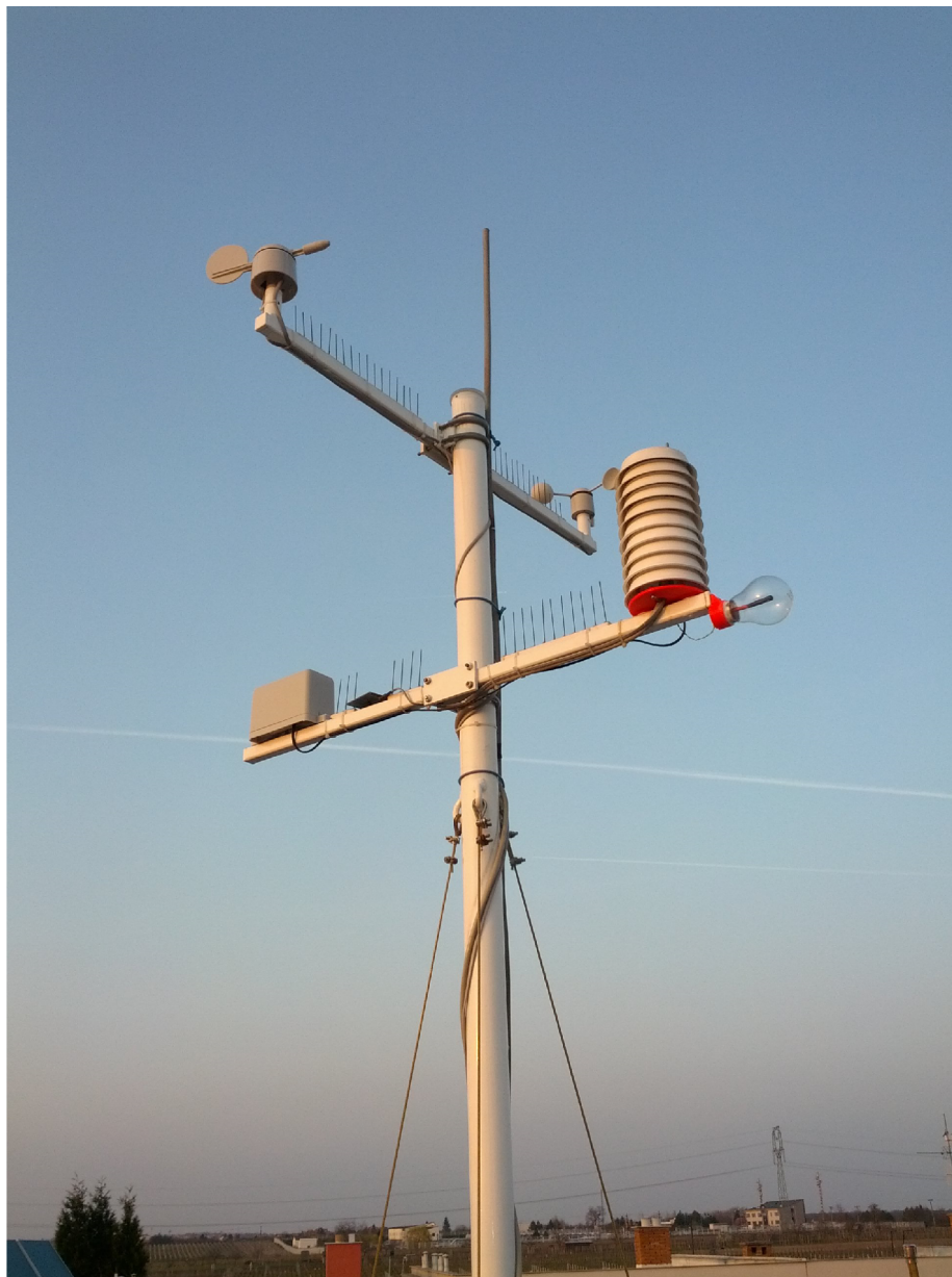
Obrázek 3.3: Hlavní část stanice v 10 m
