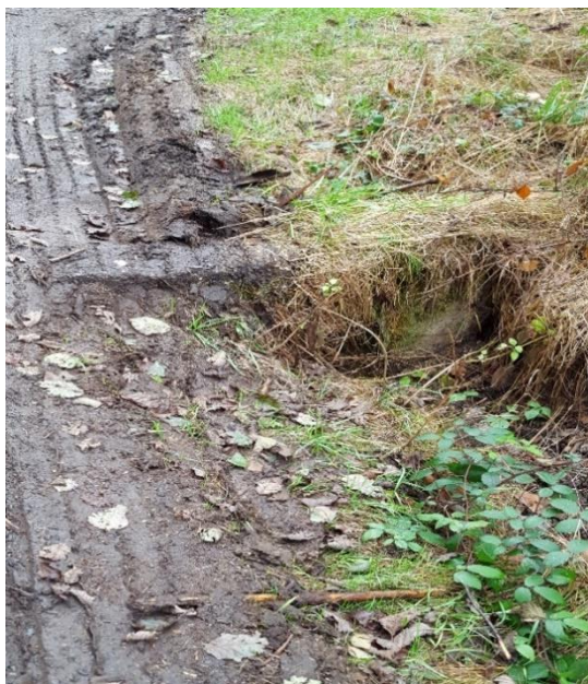
Obrázek 18: Zanesený mostek.
